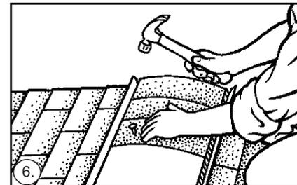
6. Прибейте гвоздями коньковую черепицу по специальным разметочным линиям, Рис.10. Гвозди должны быть достаточно длинными, чтобы полностью проникать в основание крыши (см. п.10 настоящей инструкции).
